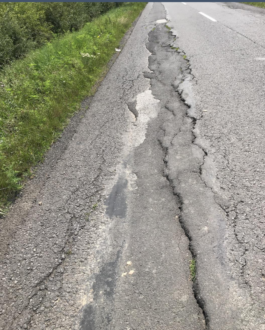
-Photos 1- Dommages liés à la sécheresse subis par la chaussée de la RD 48.
