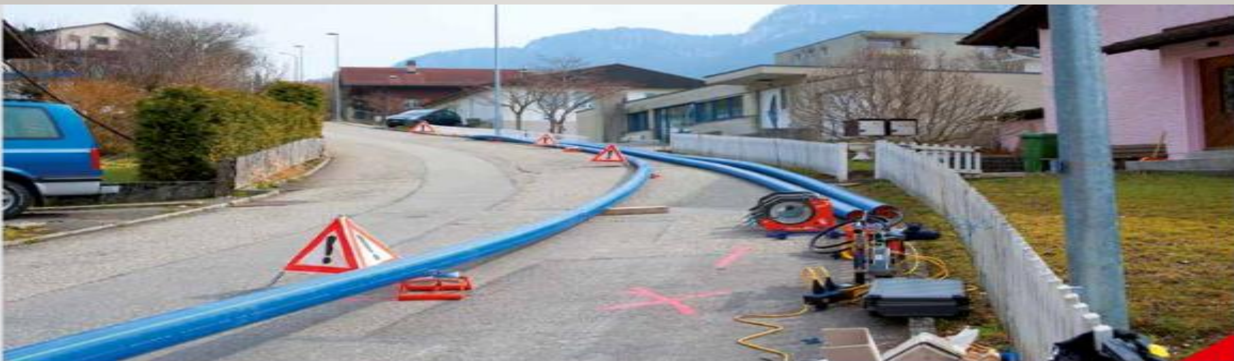
FOSSÉ D'INTRODUCTION: LES TUBES SONT PRÉPARÉ À L'AVANCE
